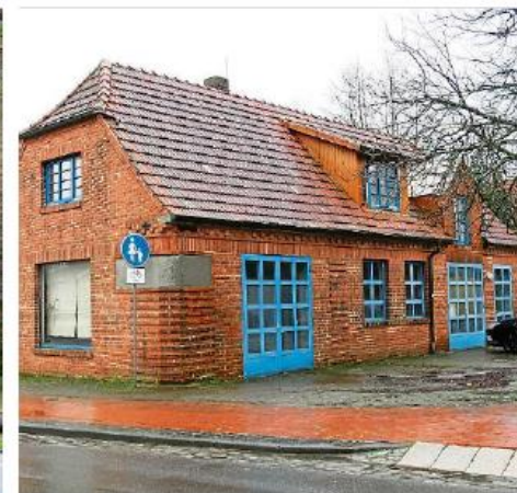
Die alte Schmiede steht zurzeit leer. Fotos: Jürgen Schwietert
